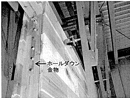
柱と梁、土台の固定方法
